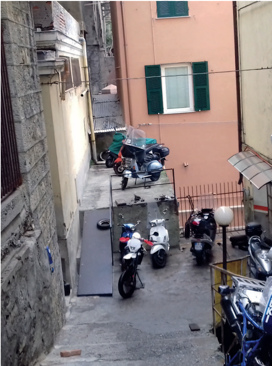
- Vista da Via Giovanni Acerbi del lato sud del fabbricato Mercato da demolire -
