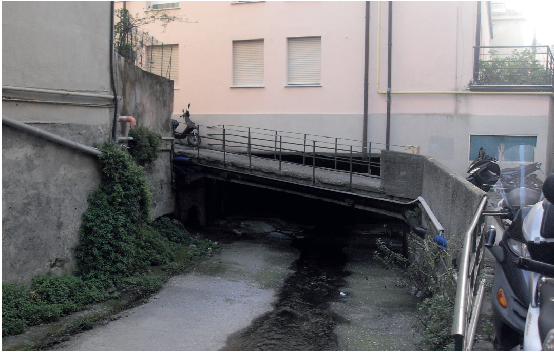
- Vista da Via Oliveto della passerella sul Rio Priaruggia da demolire –
