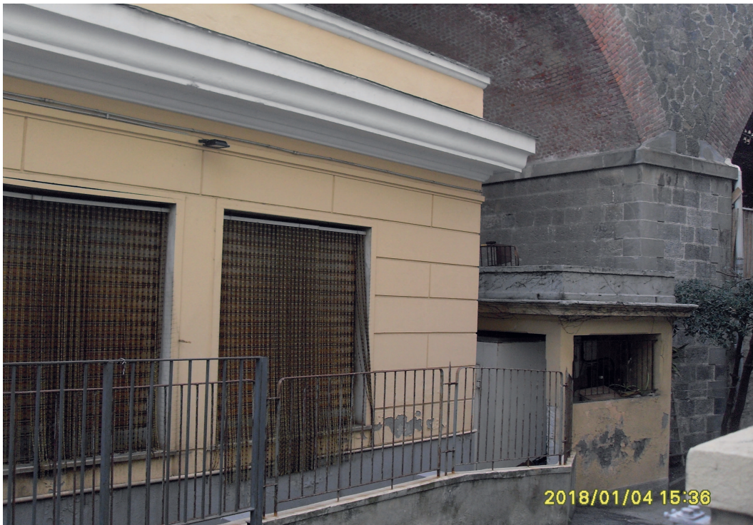
- Porzione del fabbricato Celle Frigorifere da demolire (vista da Via Gabriele Rossetti) -
