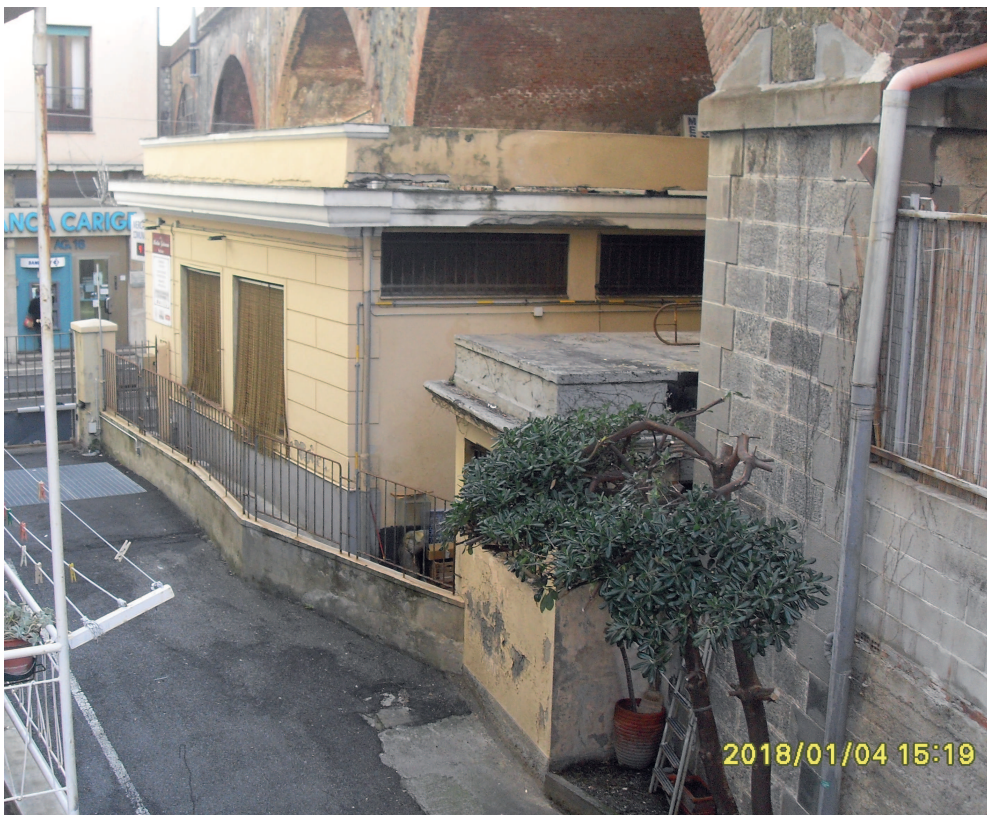
- Vista da Via Giovanni Acerbi dei due corpi da demolire -
