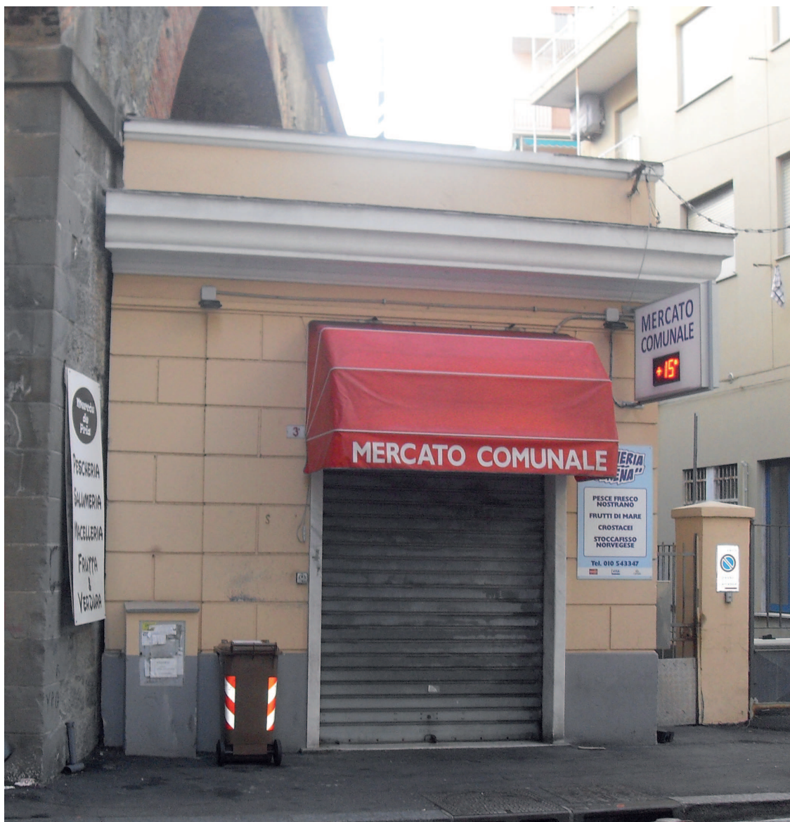
- Vista frontale del fabbricato Mercato Comunale da demolire -
