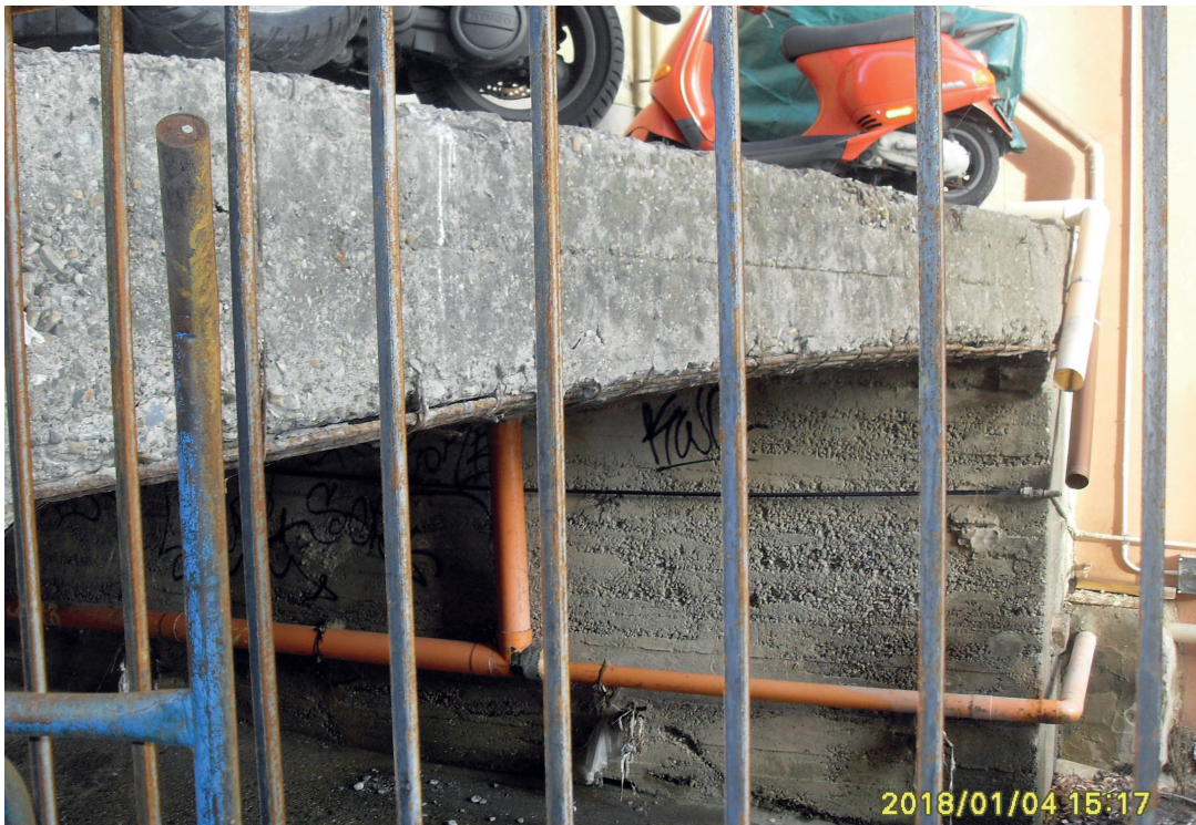
- Particolare del tratto terminale della soletta di copertura del Rio Priaruggia da demolire -
