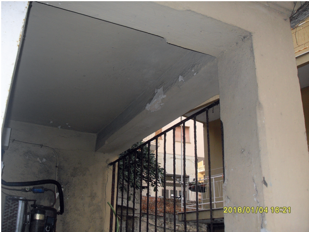
- Particolare della struttura del fabbricato Celle Frigorifere da demolire -
