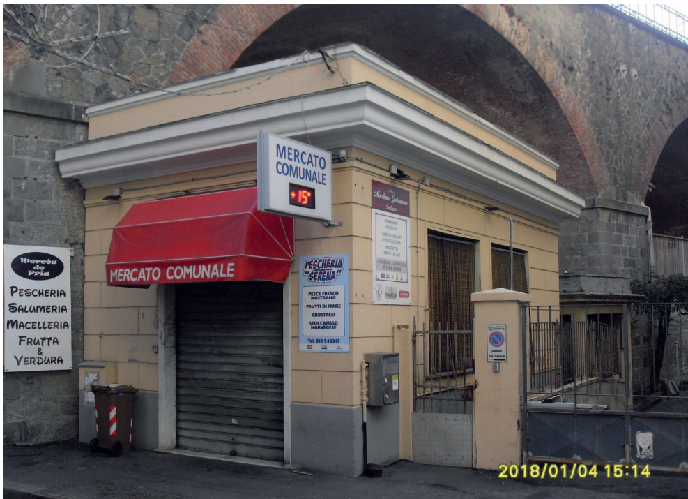
- Vista da Via Gabriele Rossetti dei due corpi da demolire -
